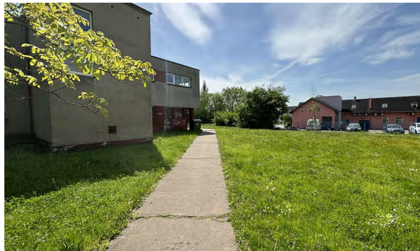
Pohled na řešený objekt a zpevněné plochy v areálu školy z chodníku od budovy ZŠ
