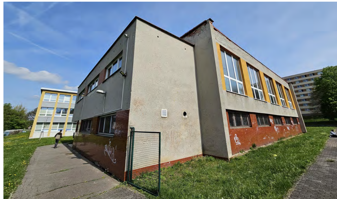
Pohled na boční fasádu objektu
