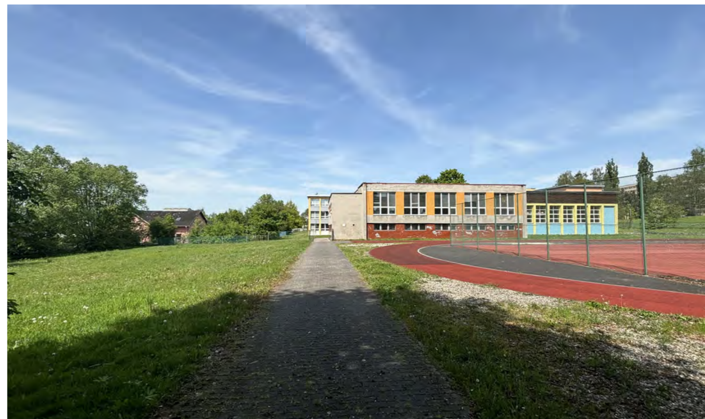
Pohled na řešený objekt a zpevněné plochy v areálu školy od ul. Rudé armády
