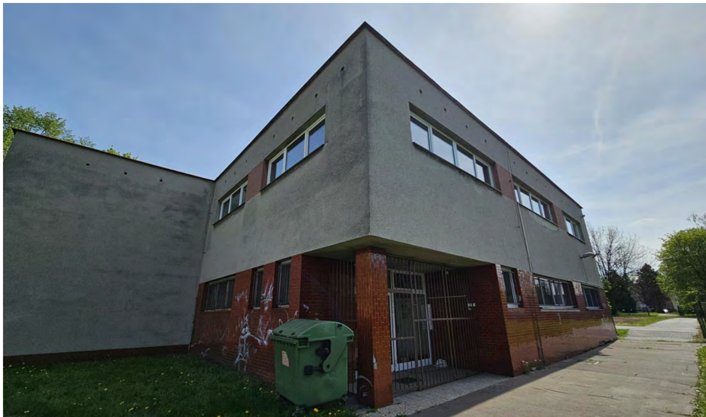
Pohled na boční fasádu objektu
