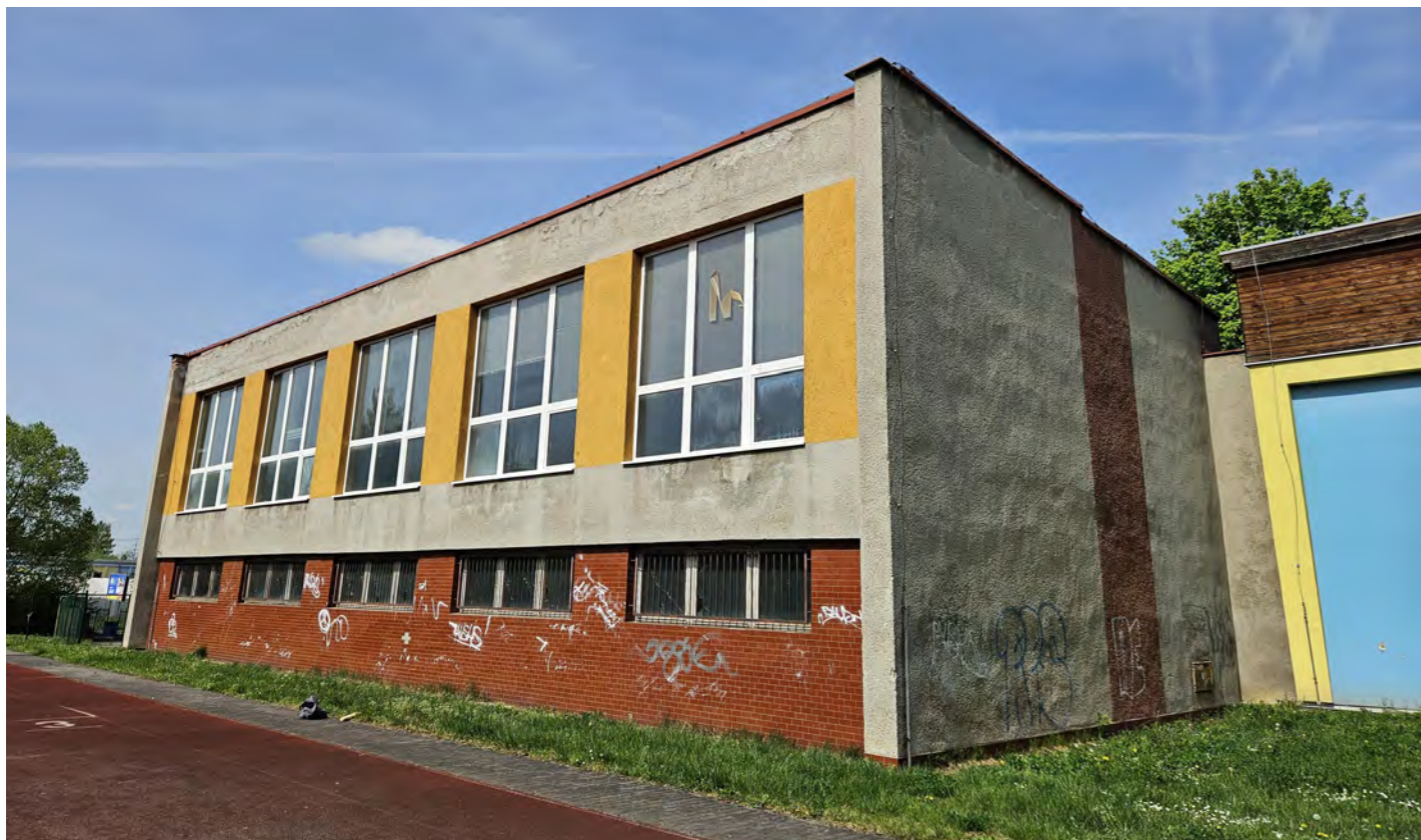
Pohled na čelní fasádu objektu
