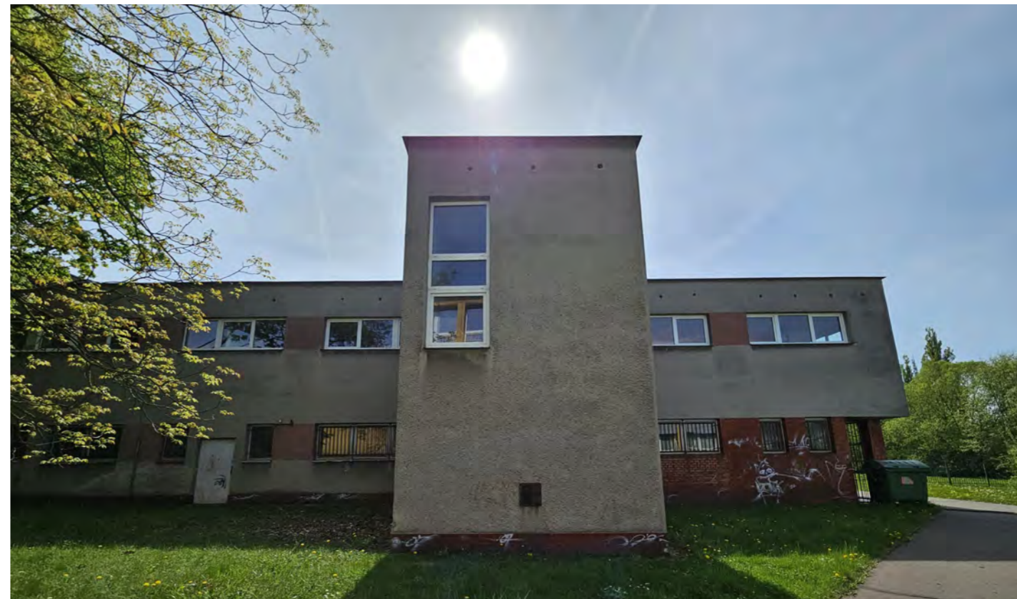
Pohled na zadní fasádu objektu
