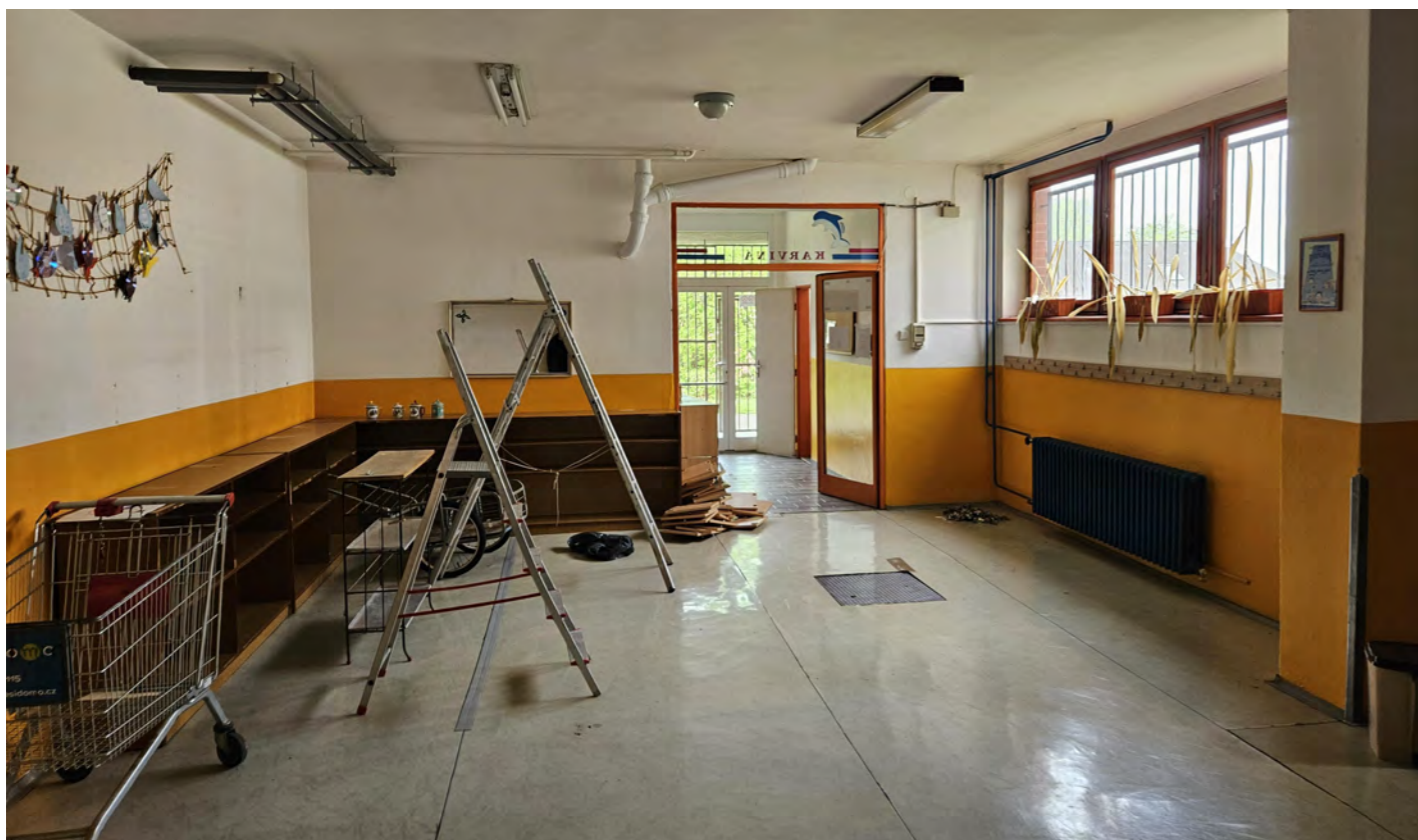
Pohled na vstupní halu a zádveř objektu
