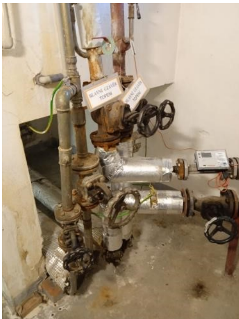
Obr. Regulační uzel pro Družinu a Jídelnu
