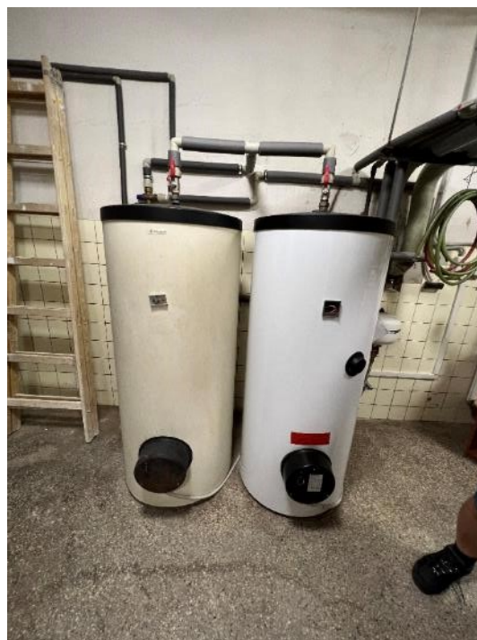
Obr. Ohřivače TV
