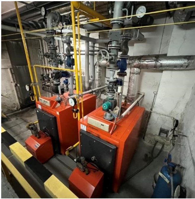
Obr. Plynová kotelna v suterénu školy
