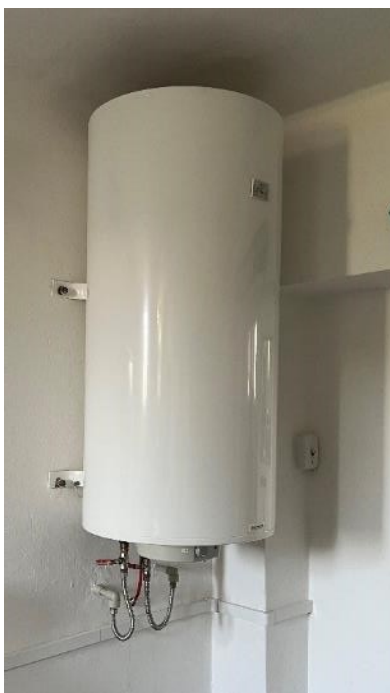
Obr. Elektrický bojler přípravy TV
