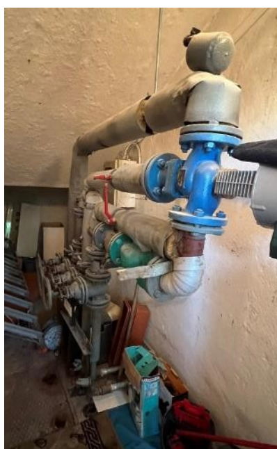
Obr. Regulační uzle pavilonu A, B, C
