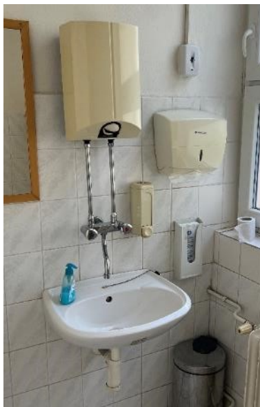
Obr. Výtoková armatura
