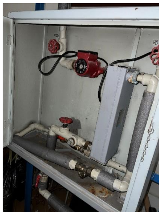
Obr. Výměník TV
