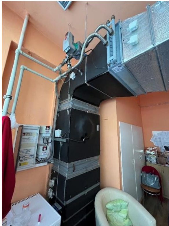
Obr. Regulační uzel pro výměník VZT
