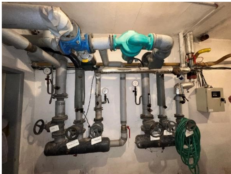
Obr. Regulační uzel ÚT Jídelna a Družina
