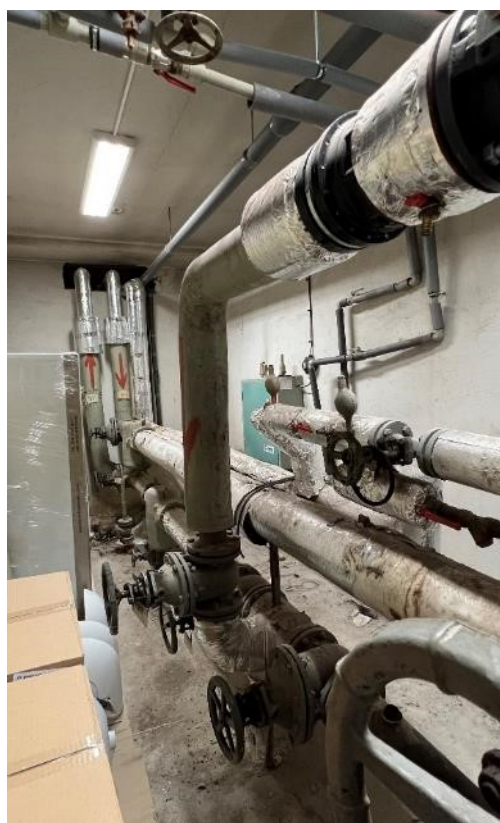
Obr. Regulační uzel ve strojovně školy
