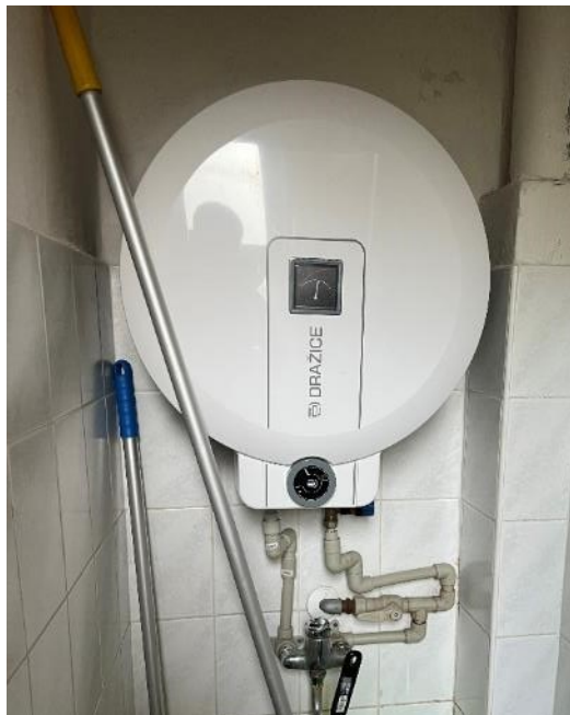
Obr. Lokální elektrické ohřivače teplé vody
