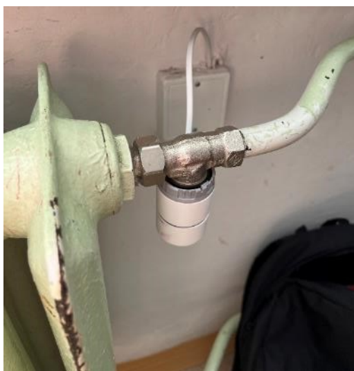
Obr. Detail OT ve třídě – IRC hlavice
