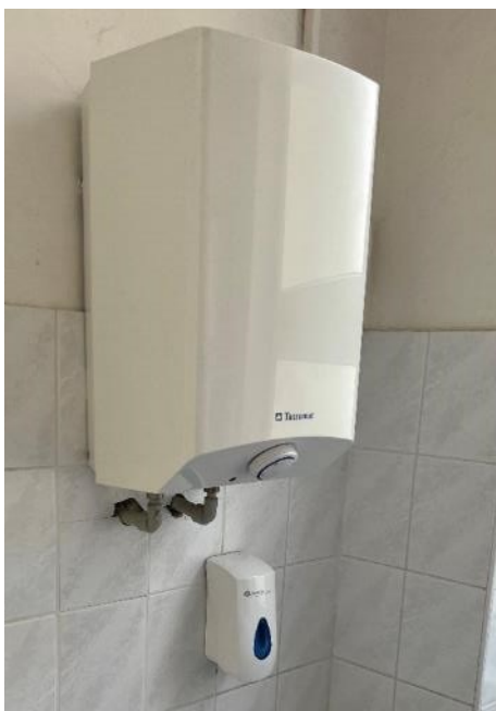
Obr. Lokální elektrické ohřivače teplé vody
