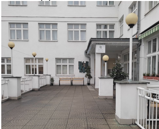
Detail vstupu do budovy
