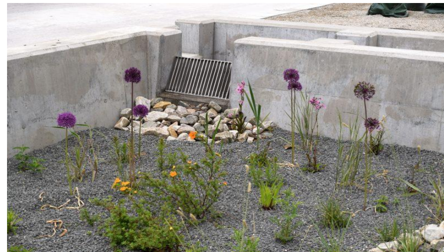
Obr. 53 – detail vtoku dešťové vody do dešťového záhonu na ulici Neptunigatan v Malmö. (Atelier Edge)
