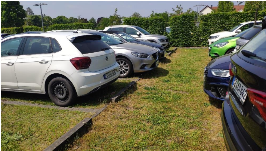
Obr. 51 – parkovací stání jsou propustná a zatravněná. Přebytečná voda je svedena do mělkých středových zasakovacích průlehů. (Dražďany, Pillnitz, 5/2023)
