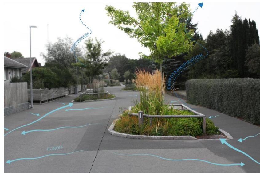
Obr. 60 – vyspádování zpevněných ploch do zasakovacích záhonů. (Atelier Edge, www.bluegreengrey.edges.se )
