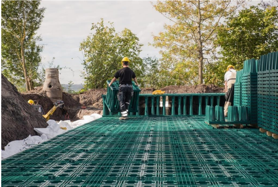
Obr. 80 – vsakovací bloky AS-RIGOFILL (asio.cz)
