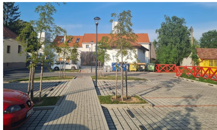
Obr. 61 – použití zasakovací dlažby na parkovací ploše v obci Líbeznice, přebytečná voda odvedena do zasakovacích prvků. (Líbeznice, 5/2023)
