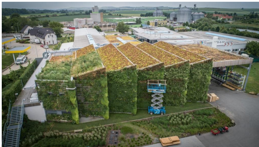
Obr. 46 – mokřadní fasády a zelené střechy haly společnosti LIKO-Noe (kořenovky.cz)
