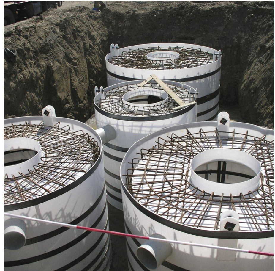
Obr. 82 – odlučovače lehkých kapalin AS-TOP (Asio.cz)
