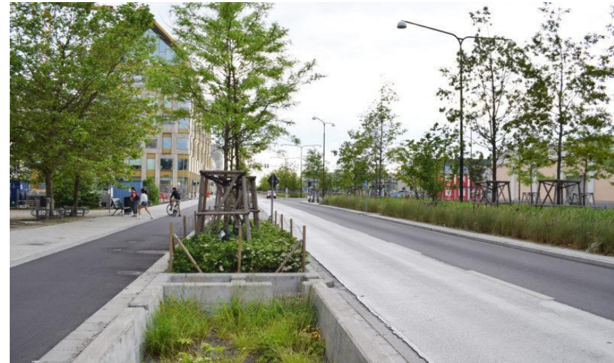
Obr. 52 – zasakovací dešťové liniové záhony sbírají vodu ze zpevněných komunikací. Současně tvoří uliční prostor, dodávají lidské měřítko, dřeviny zastiňují komunikaci, člení kategorie pozemní komunikace a přispívají k bezpečnosti. Modrozelená Ulice Neptunigatan, Malmö, Švédsko (Atelier Edge)
