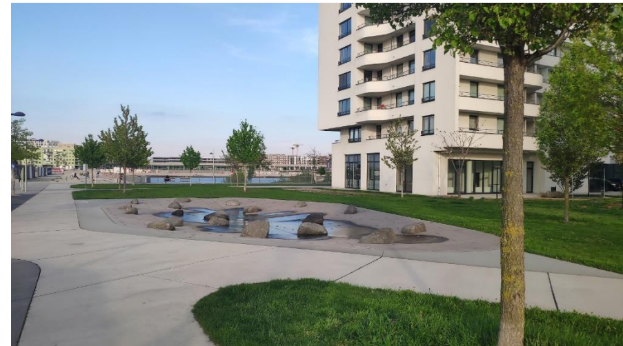
Obr. 47 – využití srážkové vody pro vodní prvky ve veřejném prostoru (Viedeň, 5/2022)
