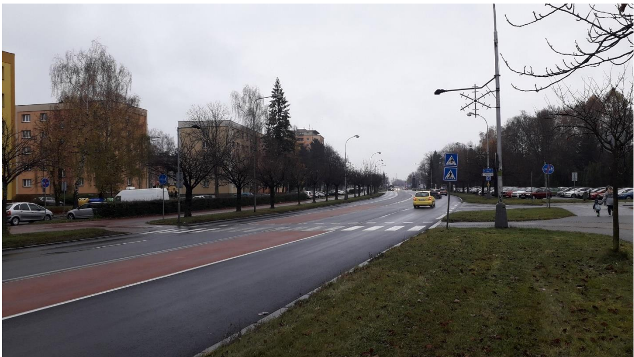
Obrázek 47 Přímknutý přejezd pro cyklisty, umožňující přejezd mimo křižovatky
