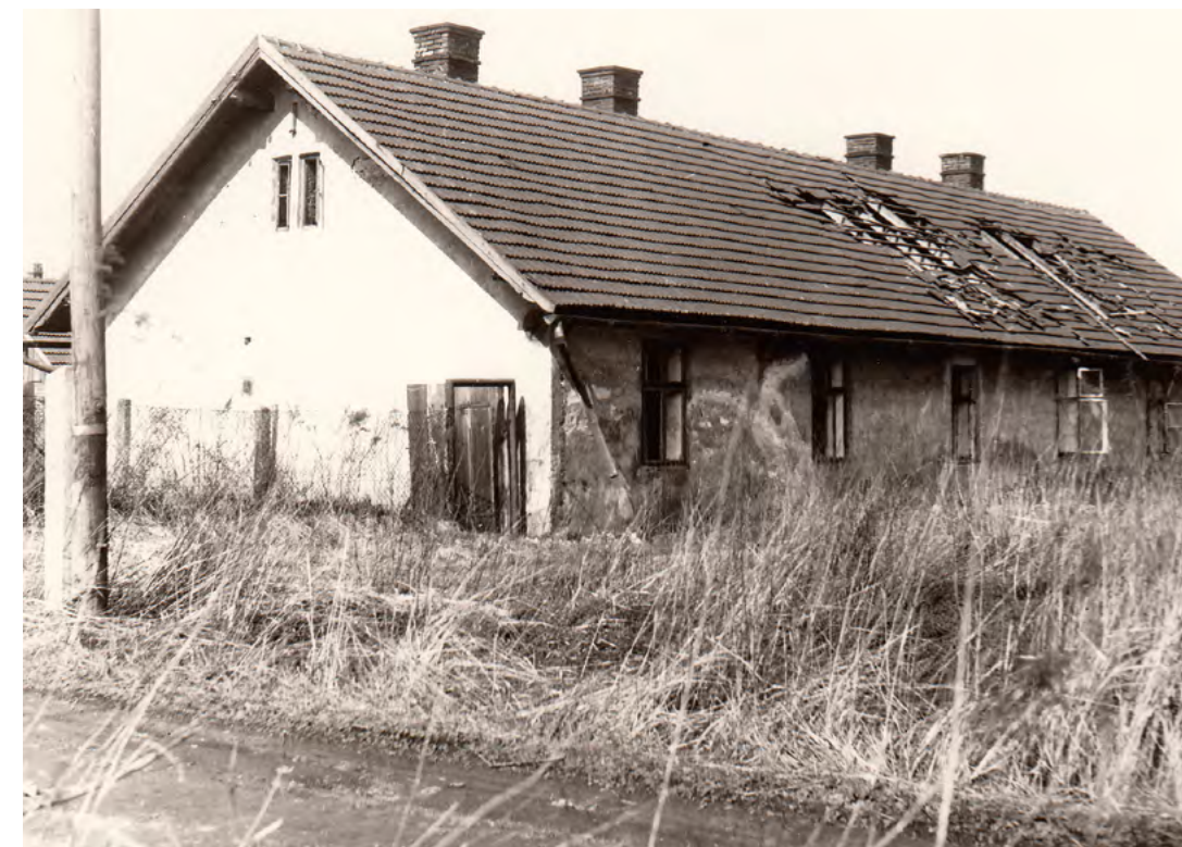
→ Dům čp. 514 krátce před demolicí v roce 1981 (SOKA Karviná)
