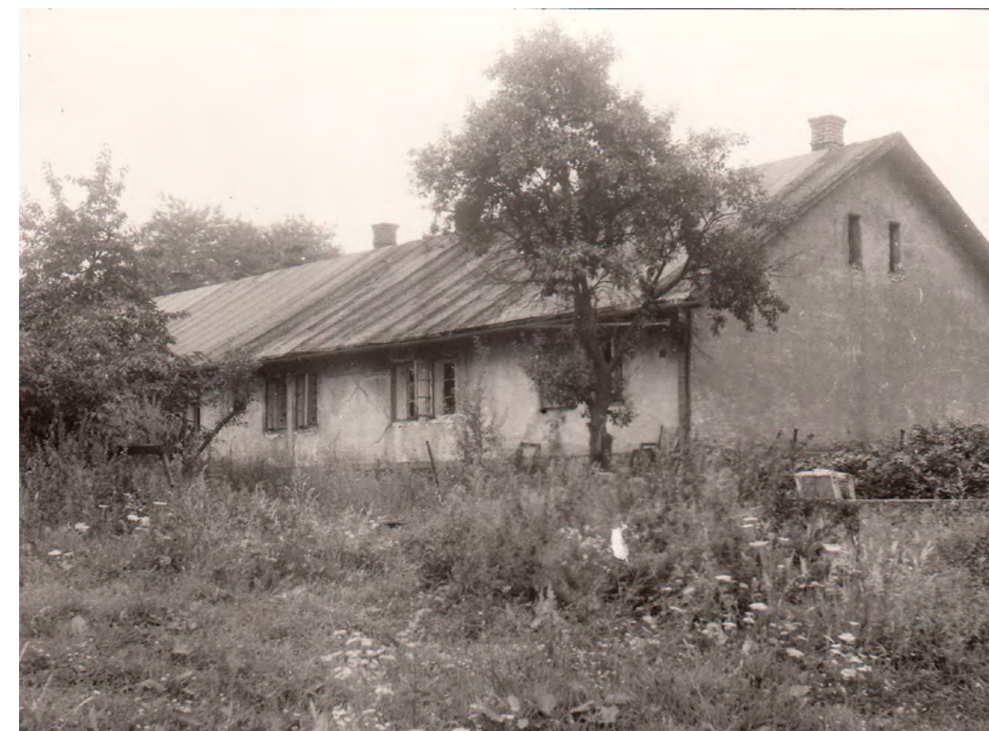
→ Dům čp. 1343 během demoličního řízení (SOKA Karviná)
