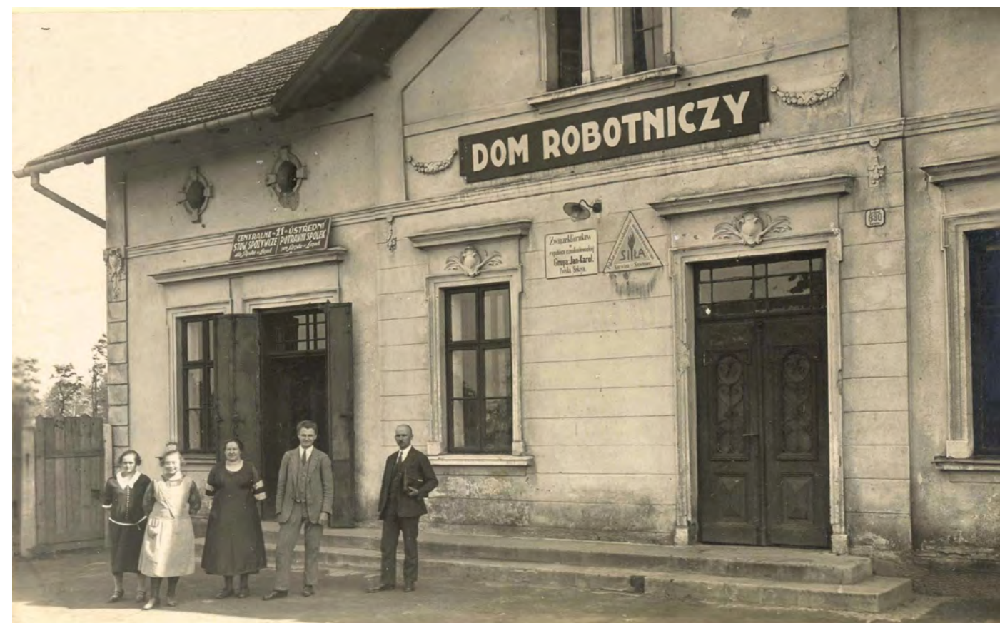
↓ Fotografie Dělnického domu na Sovinci okolo roku 1930; v budově Dělnického domu se nacházela prodejna č. 11 Ústředního potravního spolku pro Slezsko v Lazech, sídlo zde měla pobočka Svazu horníků v Československu a také Polský dělnický spolek osvětově tělovýchovný Siła v Karviné-Sovinci. (Dokumentační středisko Kongresu Poláků v ČR)
