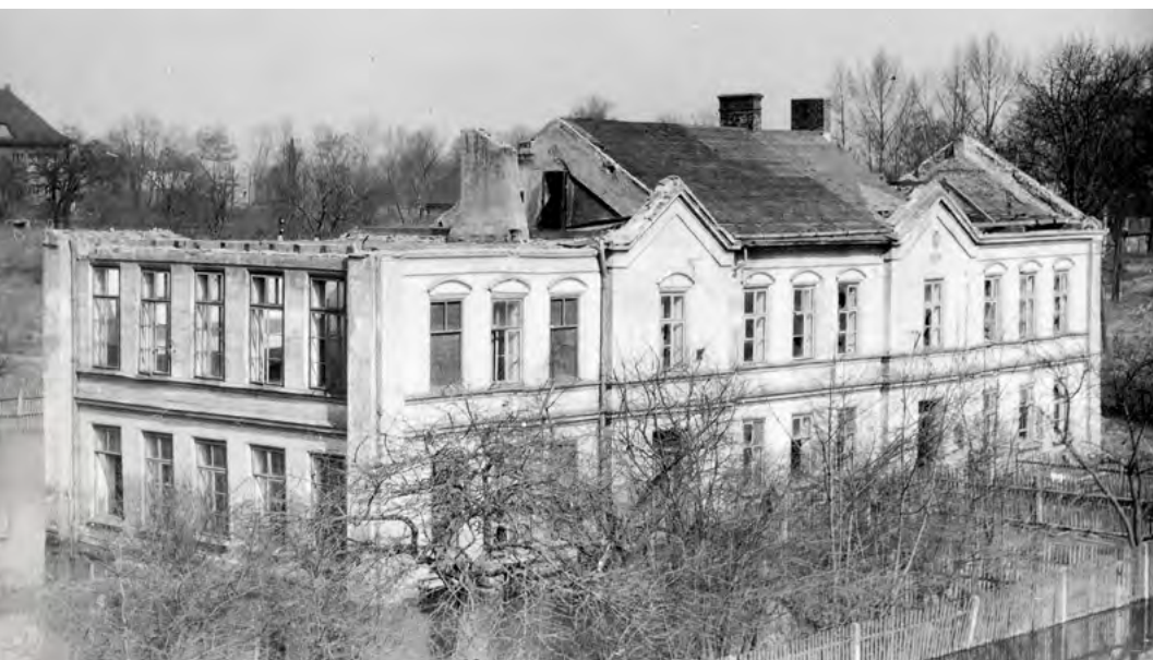
← Pohled na demolovanou budovu polské obecné školy na Sovinci, foto Jan Waloszek, 1961 (SOkA Karviná)
