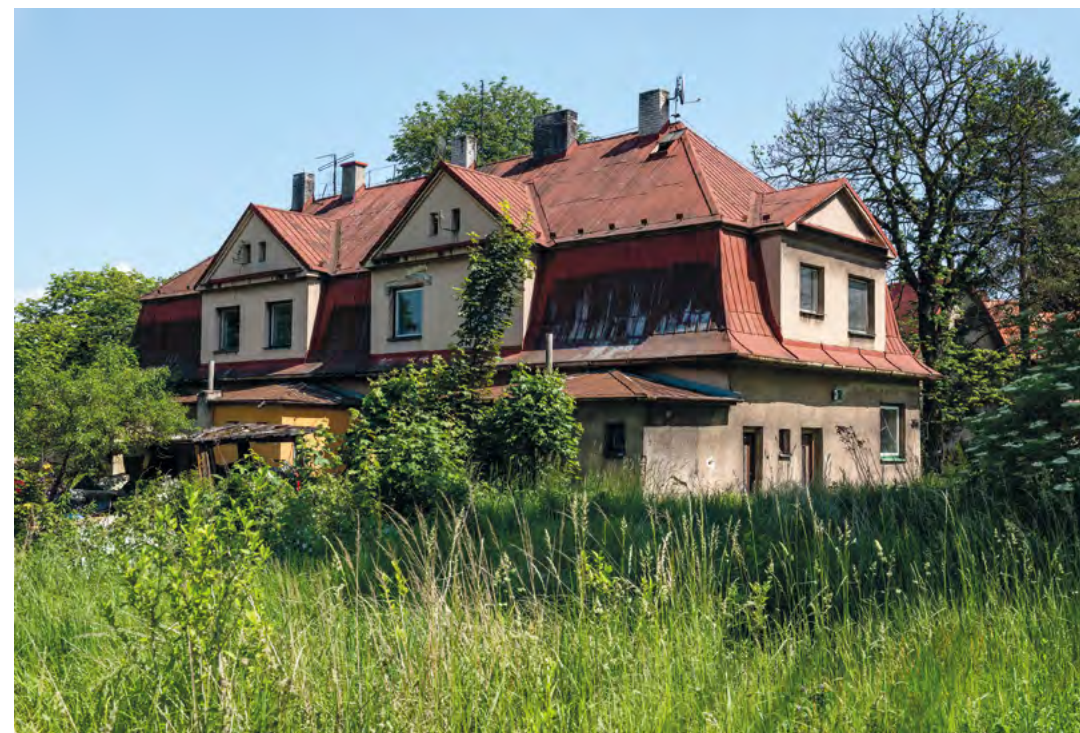
→ Domy postavené podle návrhu essenského architekta Oskara Schwera Rakouskou báňskou a hutní společností v kolonii dolu Habsburk (Pokrok) v Petřvaldě; stejné typy domů stály rovněž v Lesní kolonii v Karviné. (foto Miroslav Pawelek, 2018)
