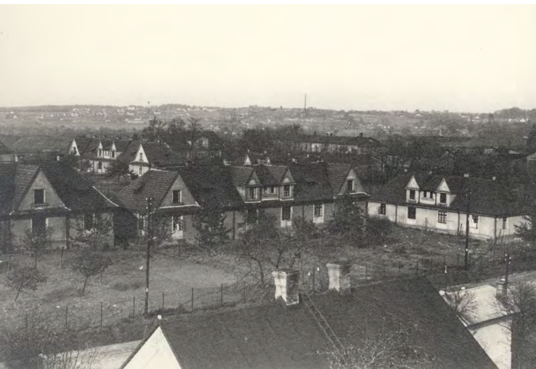
← Nedatovaná fotografie zachycující část kolonie Mexiko; snímek byl pořízen zřejmě z místa, kde stála česká škola na Novém Jorku. Při pohledu zleva doprava můžeme vidět nejprve část šestibytového domu čp. 1375, poté sousedící šestibytový dům čp. 1376 a nakonec kolmo stojící čtyřbytový dům čp. 1377. Za těmito domy se na snímku nachází ještě šestibytový dům čp. 1382. (SOKA Karviná)
