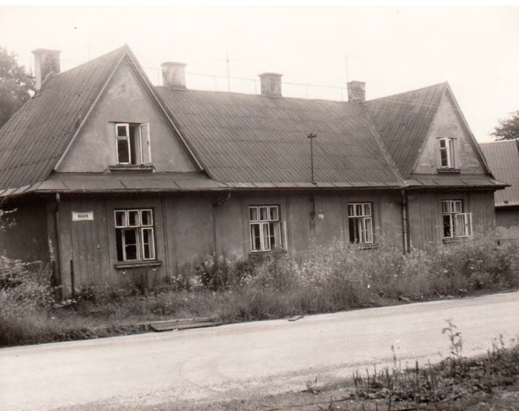
← Dům čp. 1455 krátce před demolicí v roce 1983 (SOKA Karviná)
