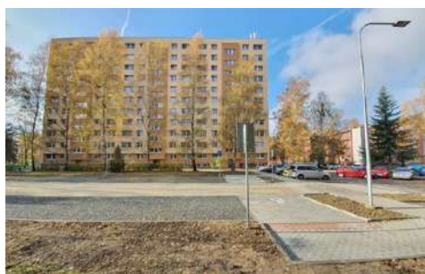
V Karviné-Hranicích na ul. Slovenské vzniklo nové parkoviště s 28 parkovacími místy včetně nového veřejného osvětlení.
