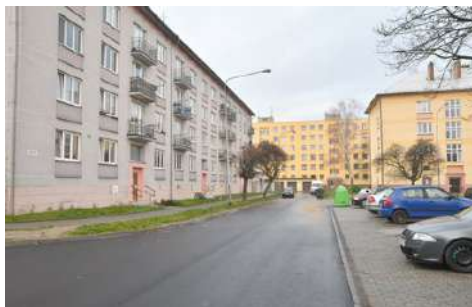
Nový povrch dostala i komunikace ul. Urxova v úseku od křižovatky s ulicí Čapkovou po garáže, a to včetně příjezdu ke garážím.
