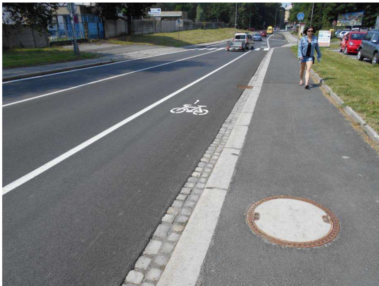
Obr. Cyklistický pruh na vozovce – foto z ul. Havířské
