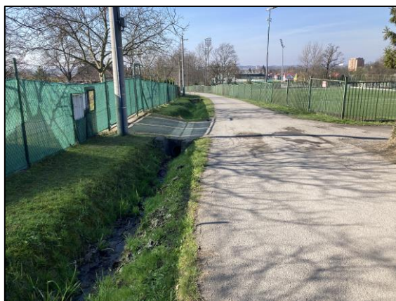
Povrchové odvodnění podél ulice Bažantnice
