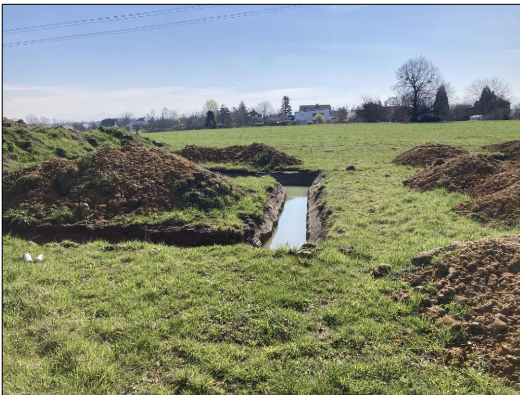
Omezená vsakovací schopnost - výkopové práce v ul. V Zákoutí
