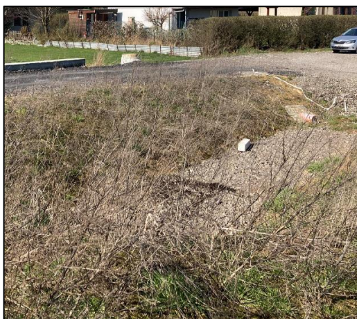
Povrchový retenční objekt vysypaný drceným kamenivem s přepadem do kanalizace (nová výstavba na ul. Jasná)
