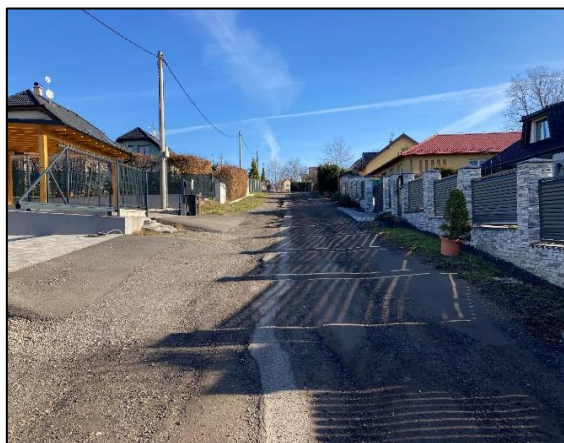
Nevyhovující stav ulice Nová
