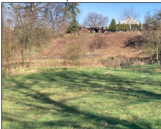
Pohled na sesuvné území SN2 stabilizované gabionovou stěnou
